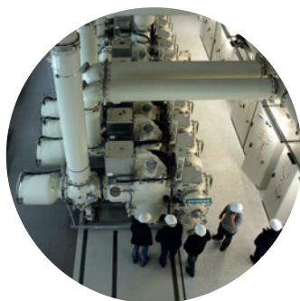
Modernizacja stacji elektroenergetycznej 110 kV
